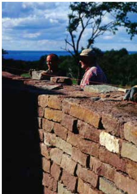
Fig 8.30 Montering av kalkstensskivor "flis" som kallmur.
