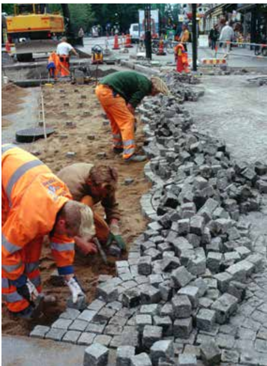
Fig 5.11 Bågsättning av smågatsten i obundet sättbruk/sand
