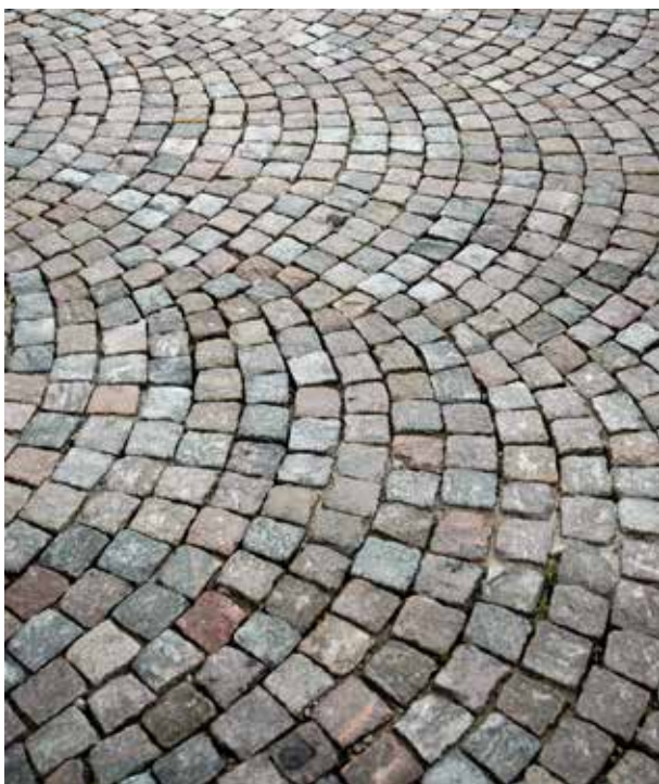
Fig 5.8 Bågsättning med smågatsten
