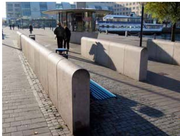
Fig 8.26 Blockstensmurar av flammad granit.
