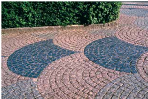
Fig 5.10 Påfågel-/fjärilsättning med smågatsten av röd och svart granit.
