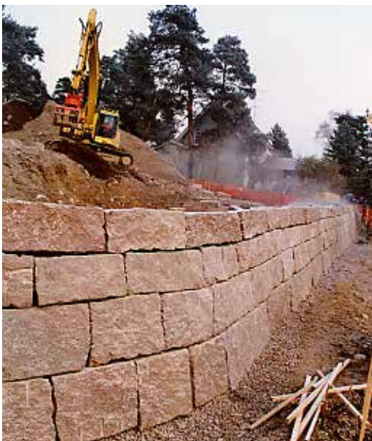
Fig 1.2 Kallmur av staplade råblock
