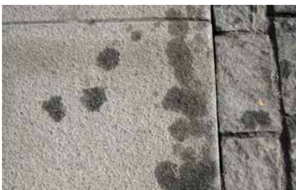
Fig 11.4 Misspdydande oljefläckar på granitramsten.
