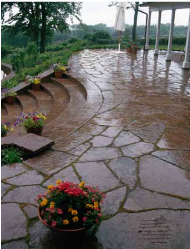
Fig 4.14 Altan med topphyvlad kalksten i oregelbundet mönster.
