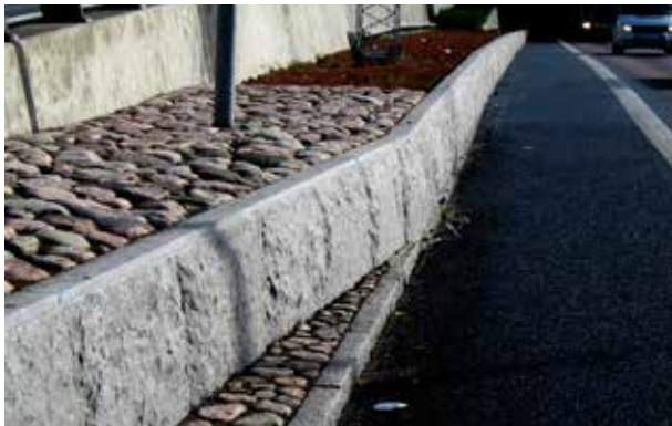
Fig 8.49 Blockstensmur av granit som stödmur och trafikbarriär
