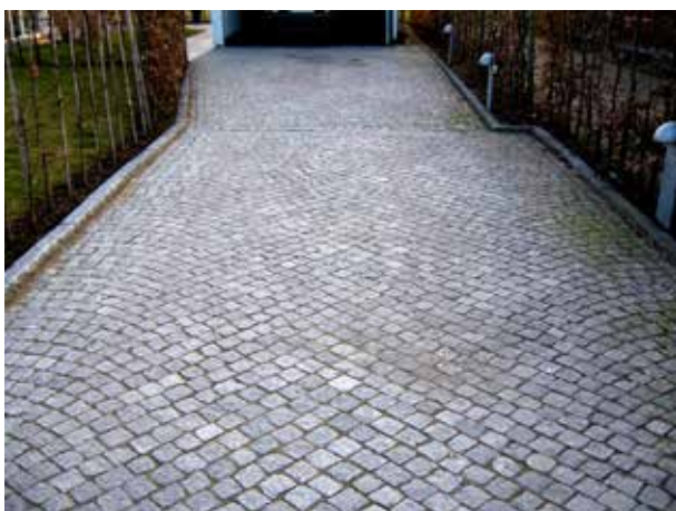
Fig 5.9 Diagonalsättning med smågatsten
