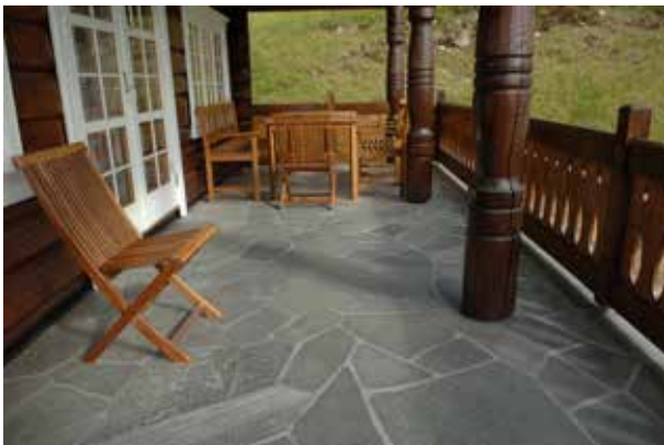
Fig 4.37 Altanbeläggning, skiffer med klovtyta.
