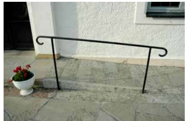
Fig 7.27 Låg ramp av kalksten för bättre tillgänglighet.
