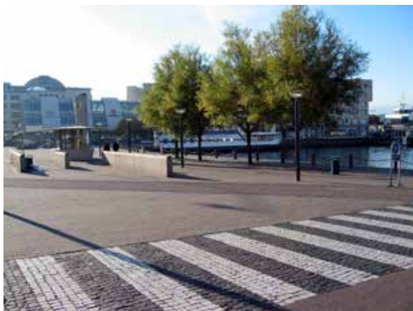
Fig 1.4 Torgyta med beläggning av gatsten och blockstensmur av granit
