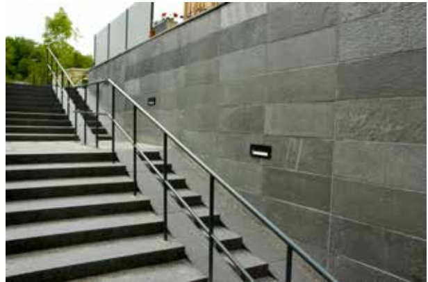
Fig 7.256 Barnvagnsramp integrerad i blockstegstrappa. Beklädnadsmur med skiffer.
