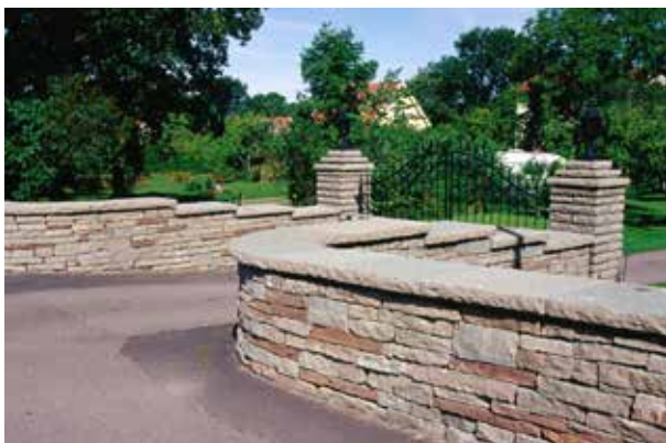
Fig 10.6 Grindstolpar och mur av kallmurad kalksten.
