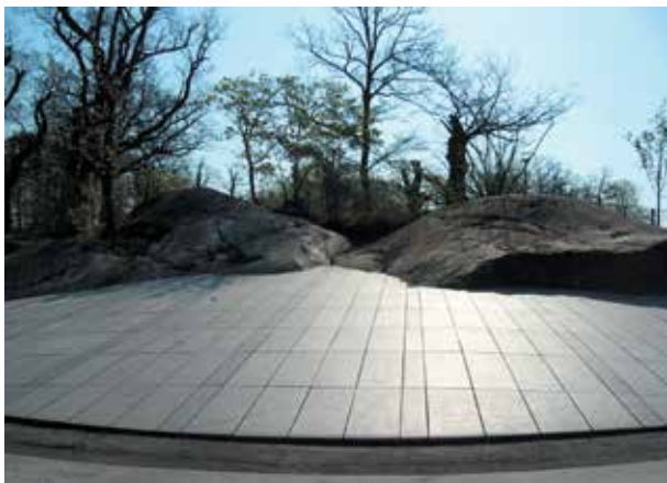
Fig 8.44 Släntbeklädnad av granitplattor i parkmiljö.
