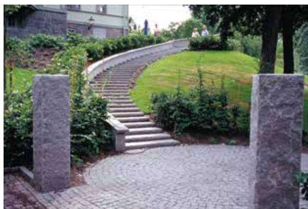
Fig 10.4 Grindstolpar av råkilad granit.
