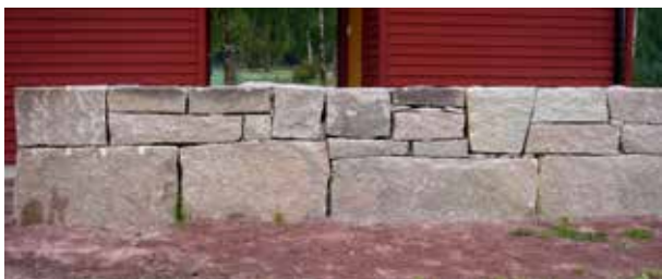
Fig 8.7 Kallmur av granitblock i rubbelförband
