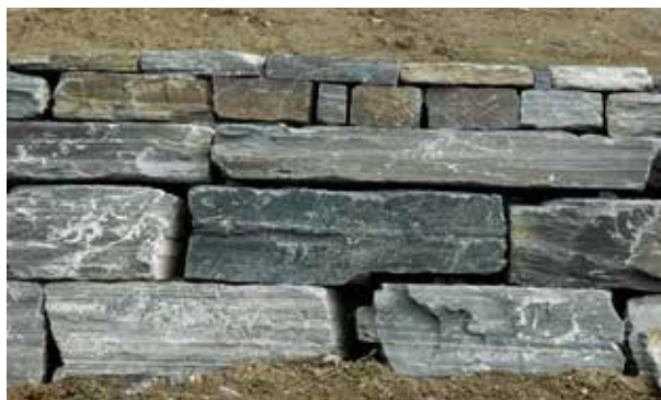
Fig 8.18 Kallmur av staplade skifferblock i kvaderförband.
