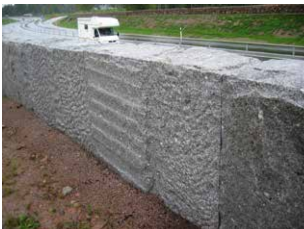
Fig 8.51 Missförstånd vid beställning från främmande land kan leda till leveranser som man inte har förväntat sig, i detta fall med mycket varierande ytbearbetning.
