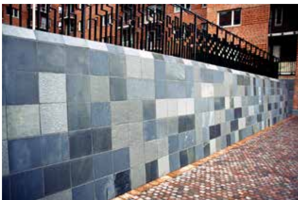
Fig 8.16 Beklädnadsmur. Skiffer med olika ytbearbetningar, klovyta, slipad och polerad. Kvadratiska plattor i rutmönster.
