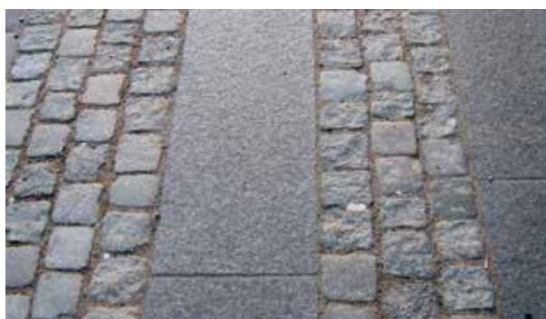
Fig 4.4 Granithäll med klippt kant mot gatstensbeläggning
