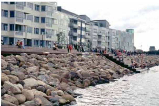
Fig 8.41 Släntbeklädning uppbyggd av runda fältstenar, som erosionskydd mot havet.
