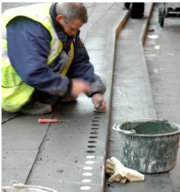
Fig 1.8 Infällning av stencylindrar med avvikande kulör som kontrastmarkering.
