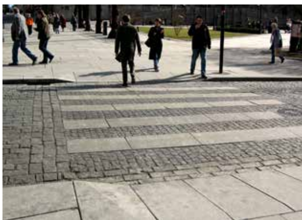
Fig 6.9 Tillgänglighetsanpassat övergångsställe.
