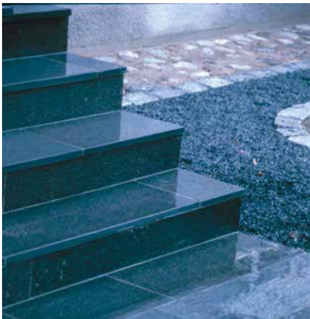
Fig 7.13 Beklädnadstrappa med steg av skiffer
