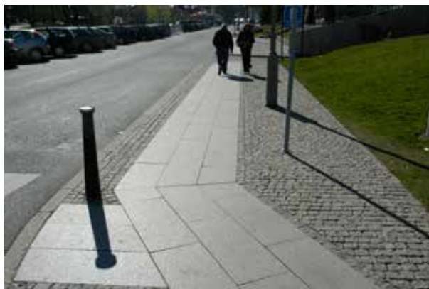
Fig 5.7 Rak stensättning/radsättning med granithällar inlagda som gångyta.
