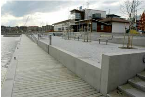
Fig 9.2 Kajläggning uppbyggd av granitblock med flammad yta.
