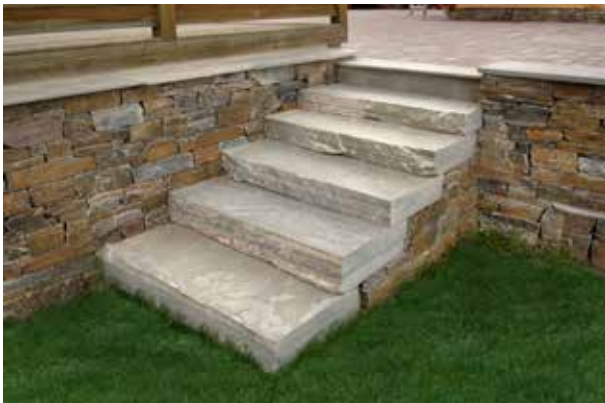
Fig 7.10 Blockstegstrappa av skiffer i anslutning till skifferkallmur.
