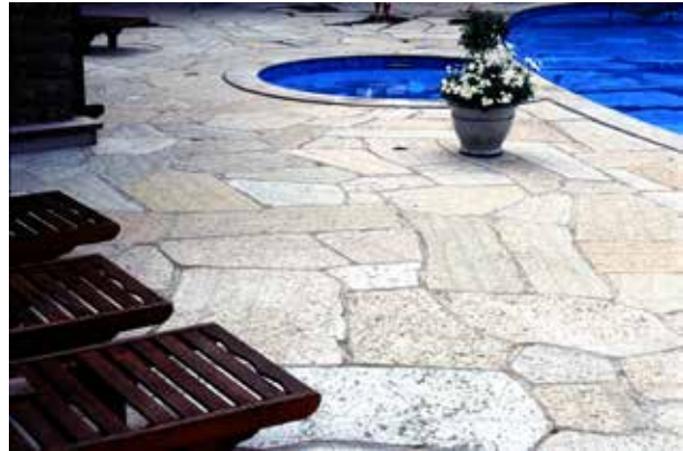
Fig 4.23 Topphyvlad kalksten i oregelbundet mönster runt pool.
